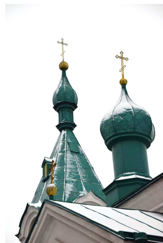
Pokrycie dachowe, obróbki blacharskie i orynnowanie – mocno pofalowane i nie zapewniające szczelności
