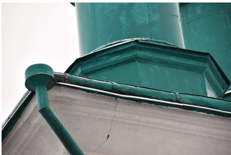
Pokrycie dachowe, obróbki blacharskie i orynnowanie – mocno pofalowane i nie zapewniające szczelności
