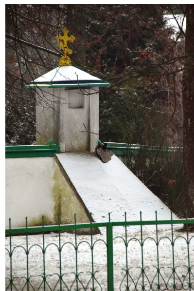
Mur kamienny, częściowo tynkowany – duże ubytki spoinowana, odpadające tynki cementowe. Czapa z blachy tzw. dachówkowej - współczesna
