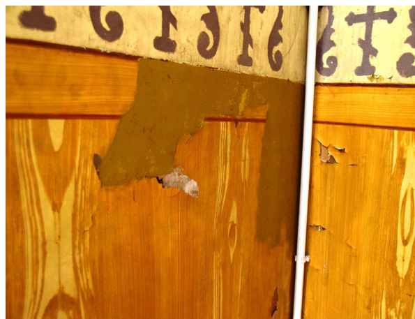
Ściany wewnętrzne – lamperia olejna, odpadająca od ściany
