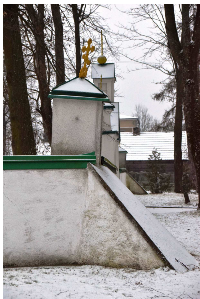
Mur kamienny, częściowo tynkowany – duże ubytki spoinowana, odpadające tynki cementowe. Czapa z blachy tzw. dachówkowej - współczesna
