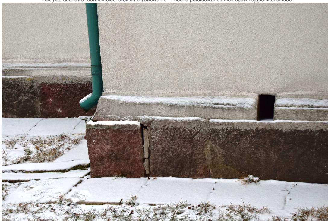
Podmurówka – braki w spoinowaniu. Brak kratki wentylacyjnych podmurówki. Rury spustowe zakończone zbyt wysoko nad terenem.
