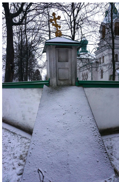
Mur kamienny, częściowo tynkowany – duże ubytki spoinowana, odpadające tynki cementowe. Czapa z blachy tzw. dachówkowej - współczesna
