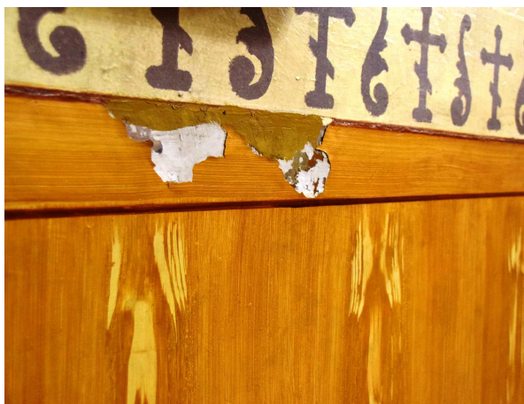
Ściany wewnętrzne – lamperia olejna, odpadająca od ściany
