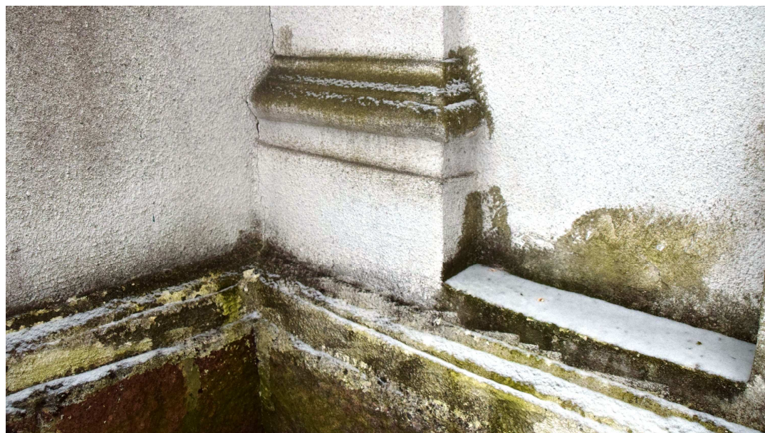
Ściany zewnętrzne – liczne spękania, wykwyty, zagrybienia, miejscami odpadające tynki.
