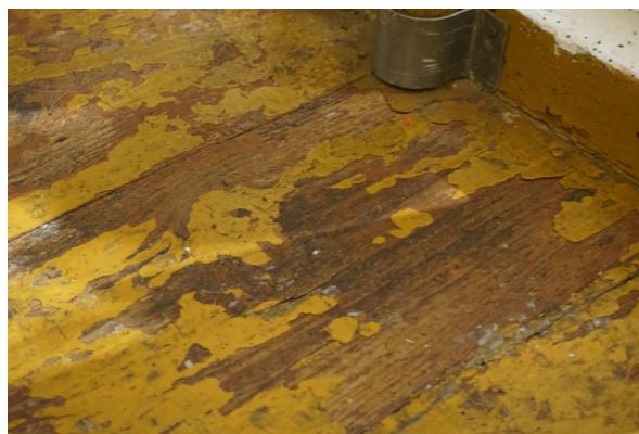
Podłoga – drewniana, mocno zniszczona, miejscami kołyszająca się – wymaga przeglądu i remontu
